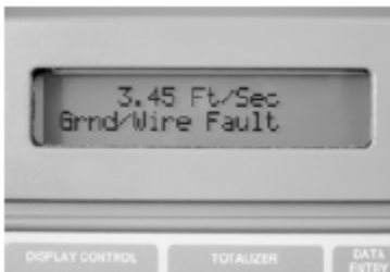
Ошибки заземления и кабелей, отображаемые на экране дисплея
